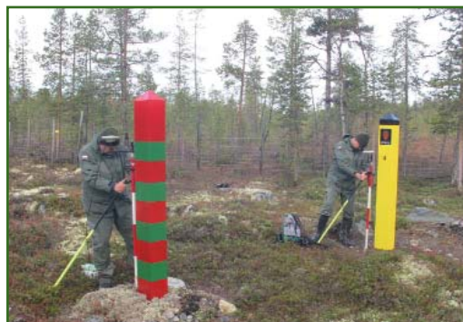
Спутниковые определения координат пограничных столбов на российско-норвежской государственной границе, 2011 г. Фото А.Н. Осанкина
